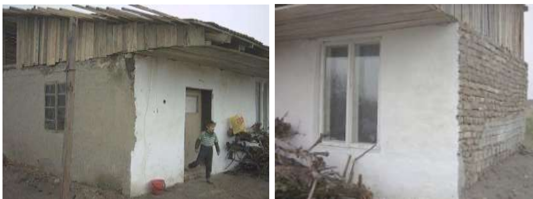
Sandas Haus mit Lehmziegel- wänden und neuem Dach
