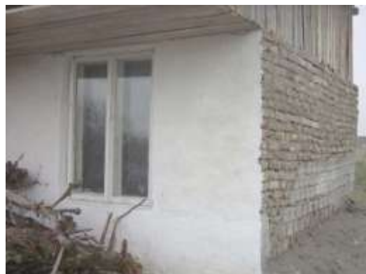
Sandas Haus mit Lehmziegel- wänden und neuem Dach
